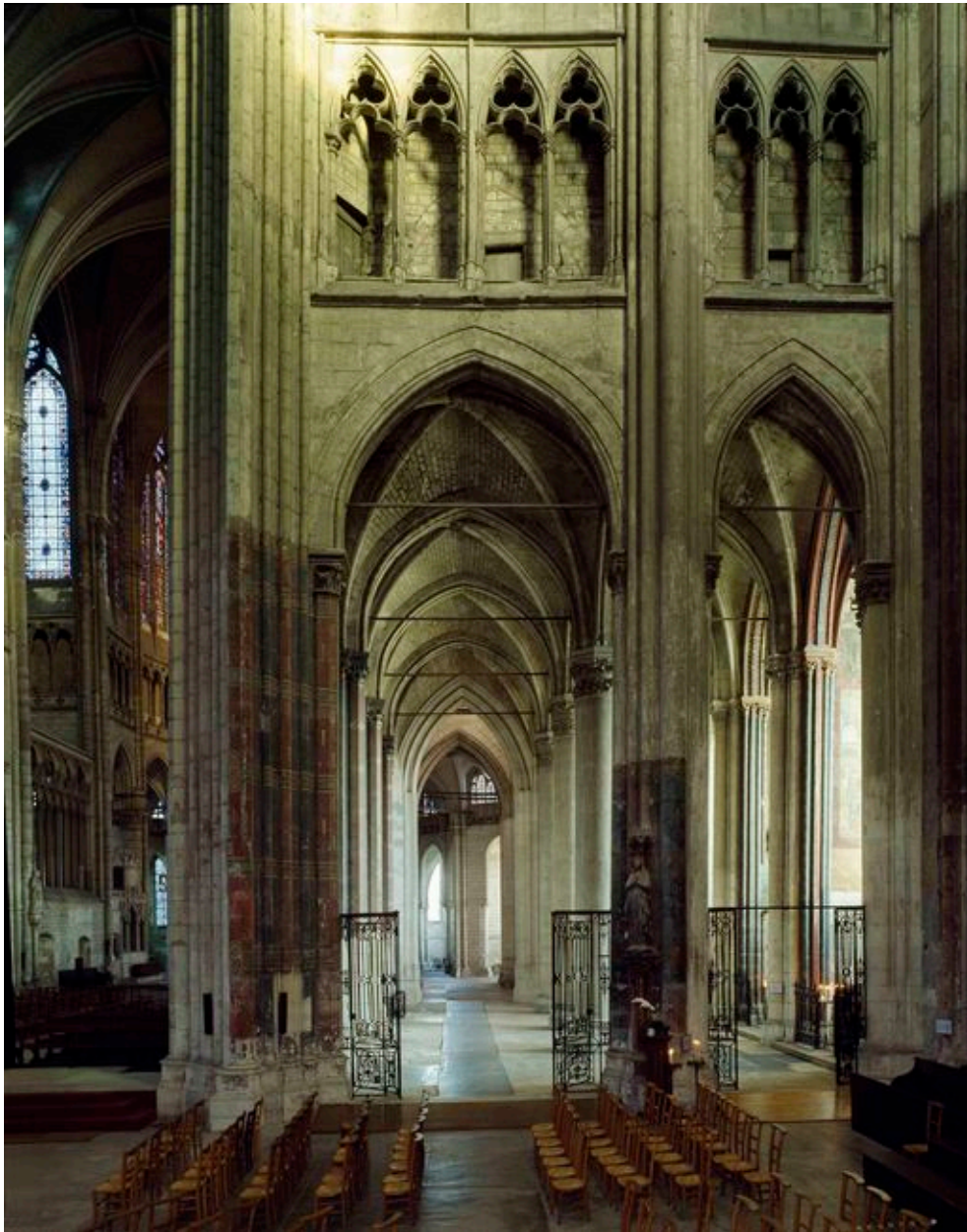
Vue du collatéral sud du choeur, depuis le grand transept.
