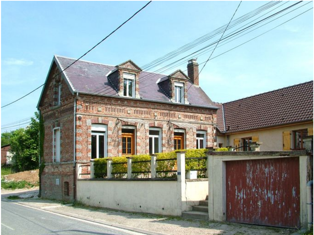
Vauchelles-lès-Domart, maison, 3 rue de Flixecourt, limite des 19e et 20e siècles.
