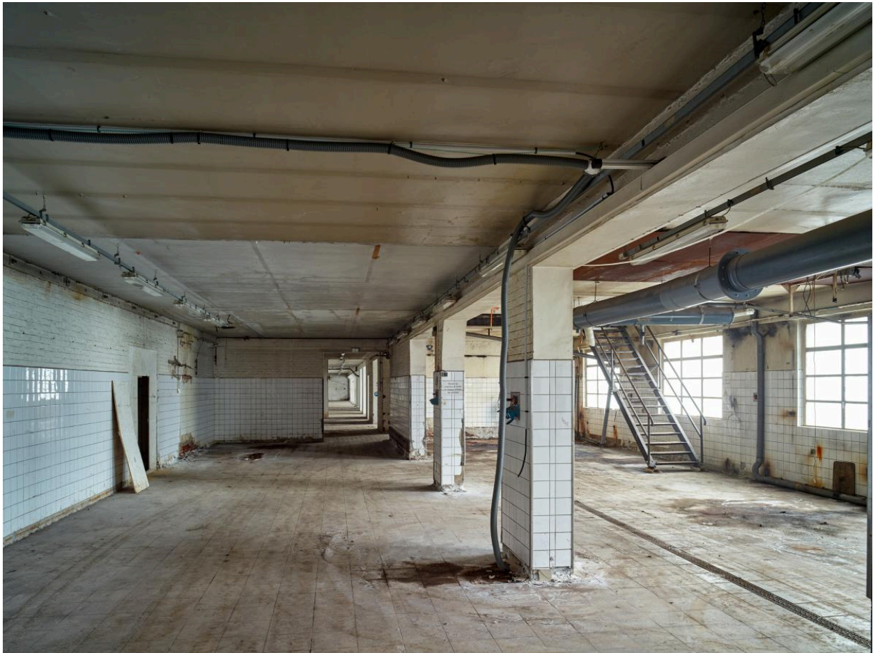
Vue intérieure du rez-de-chaussée du magasin aux produits chimiques (AD).
