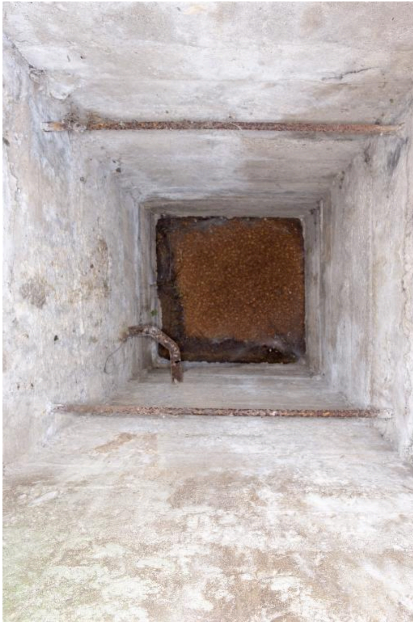
Vue zénithale du poste d'observation
