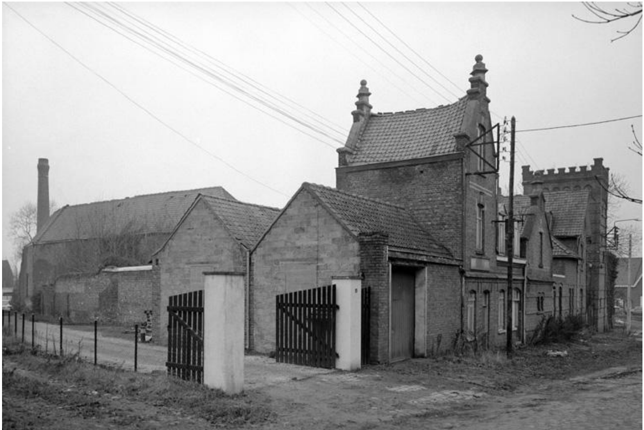
Vue générale vers le nord-ouest.
