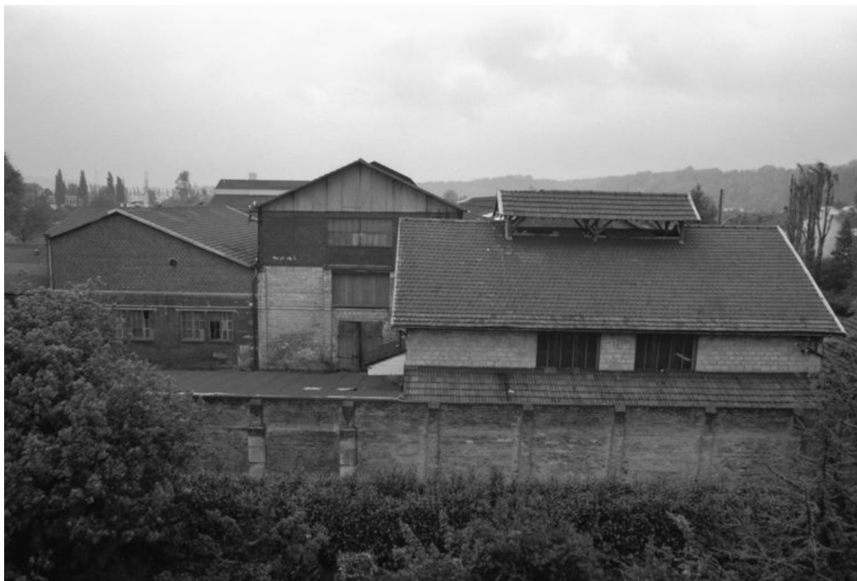
Ateliers de fabrication et dépendances, vue des toitures et des murs de clôture.
