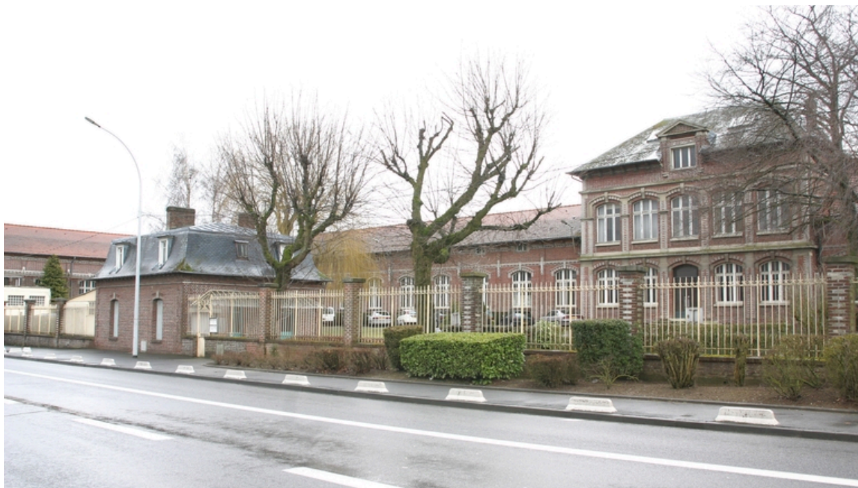
Le site vu depuis la rue de Guise.
