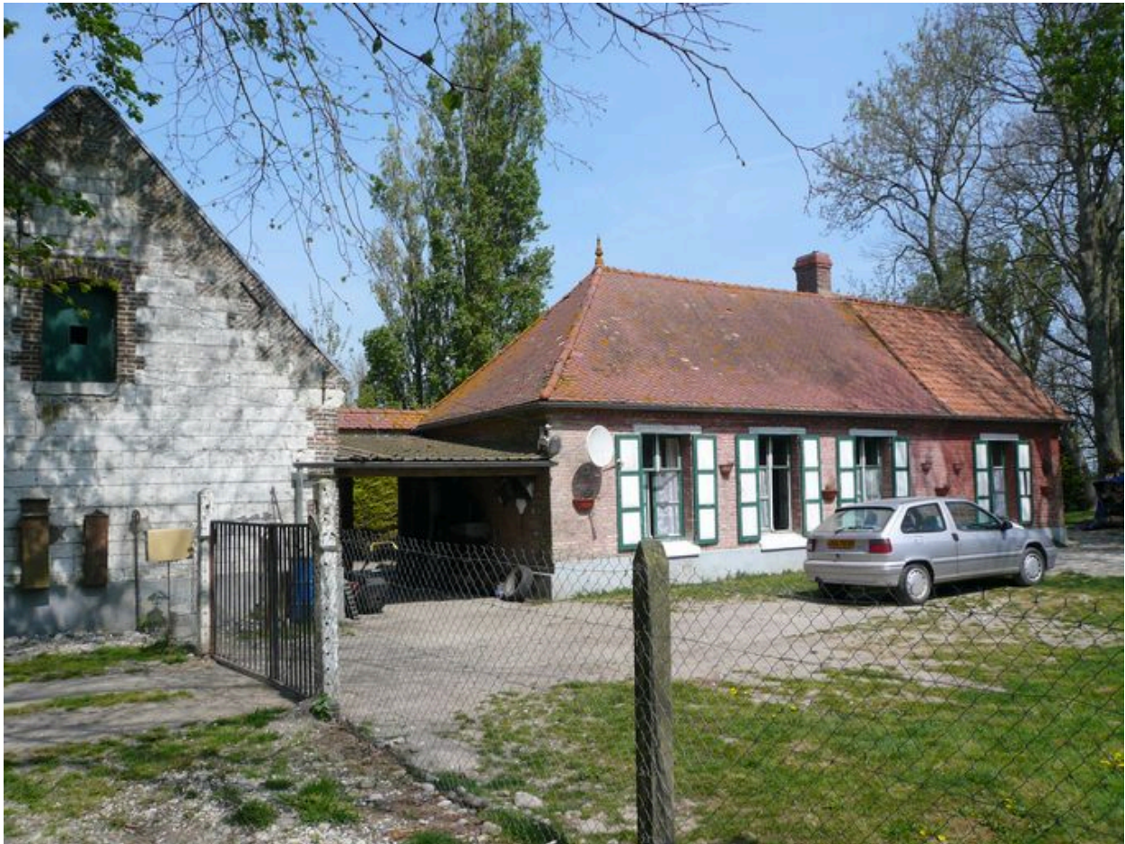
Vue sur le petit logis situé au sud-est de la propriété.
