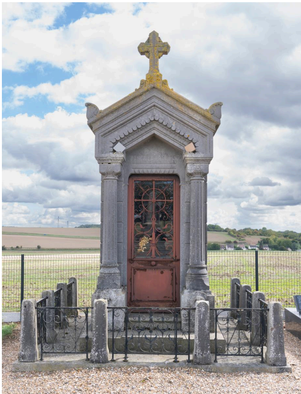
Tombeau en forme de chapelle de la famille Poncelle-Vatripon, signé Ollivier à Beauvais.
