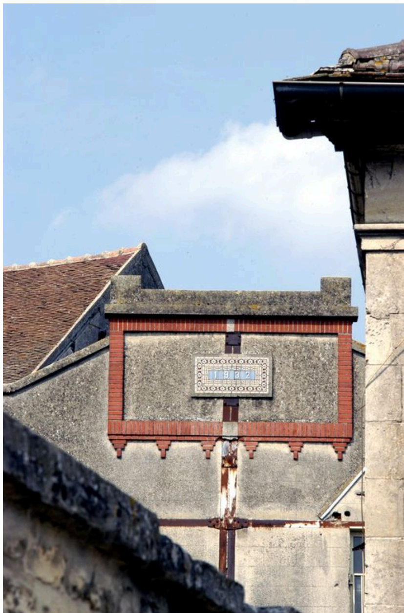
Détail du pignon du bâtiment d'entrée de la minoterie portant la date de 1932.
