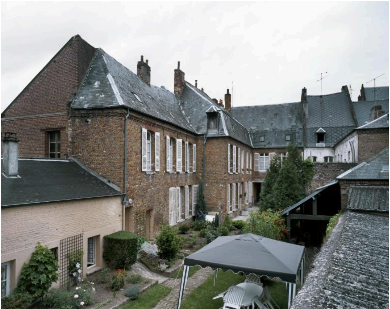
Vue des façades sur cour.
