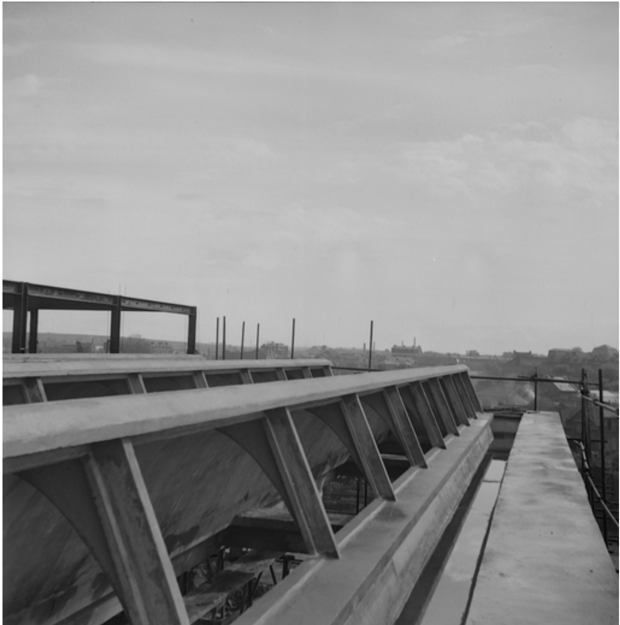
Les sheds des services généraux, vers 1950 (IFA).
