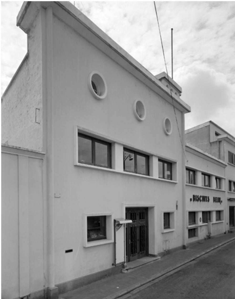
Vue de la façade sur la rue Henri Petit.
