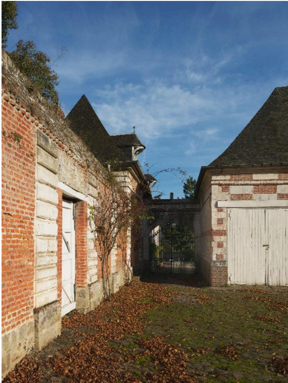
Passage entre la cour et la basse-cour (vue large).
