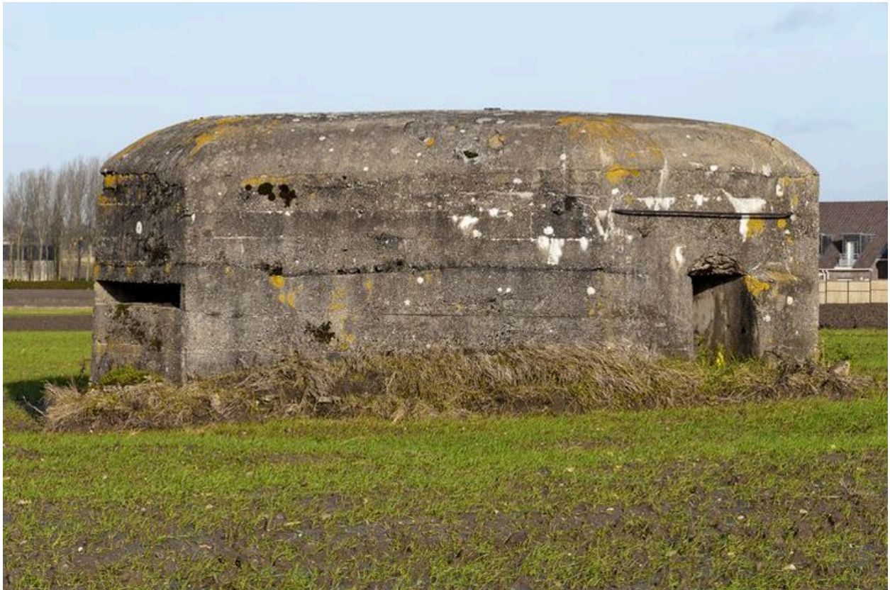
Vue générale, vers le nord-est
