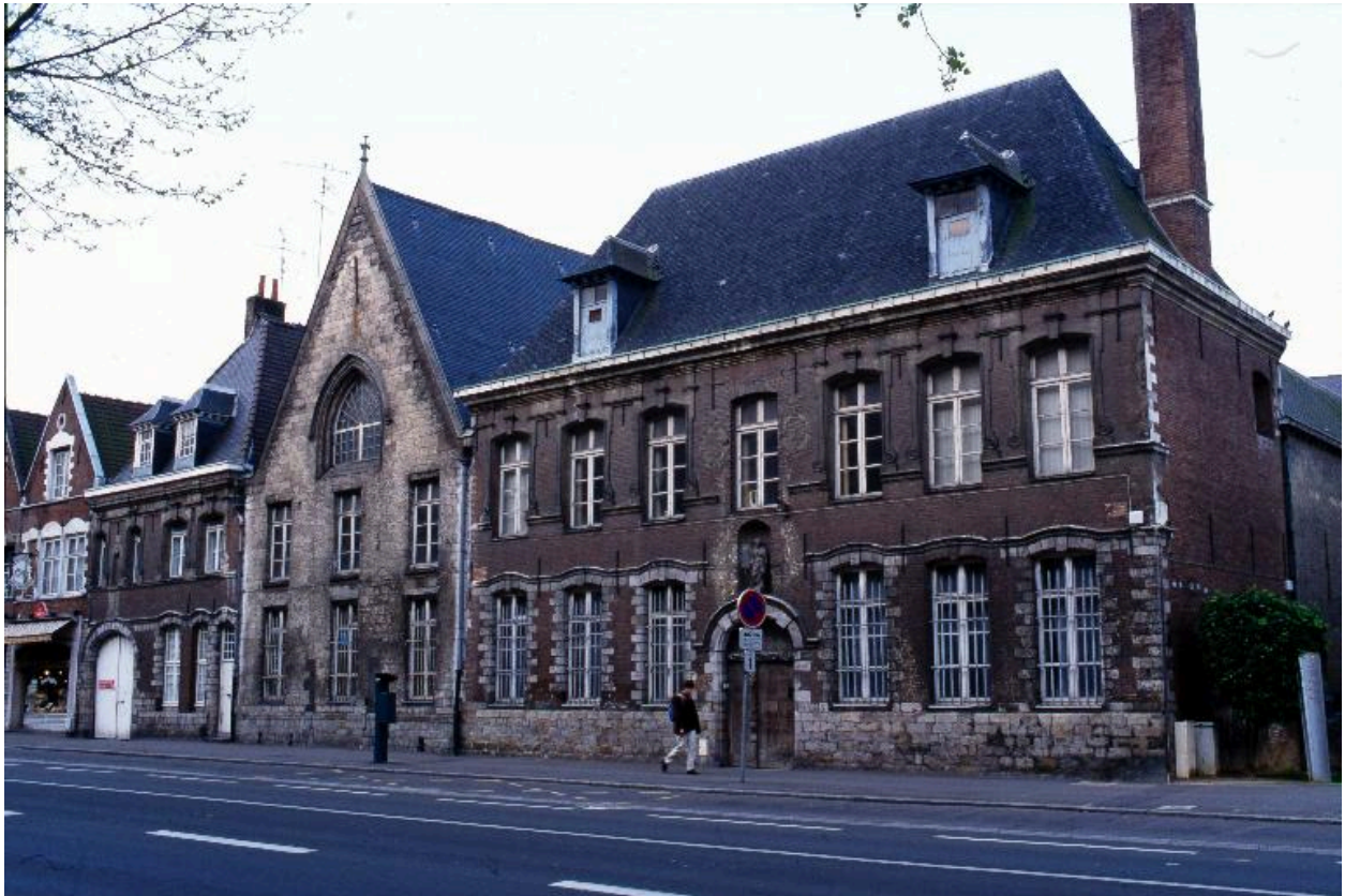
Elévation sur la rue de Paris, vue générale prise de trois-quarts droit.
