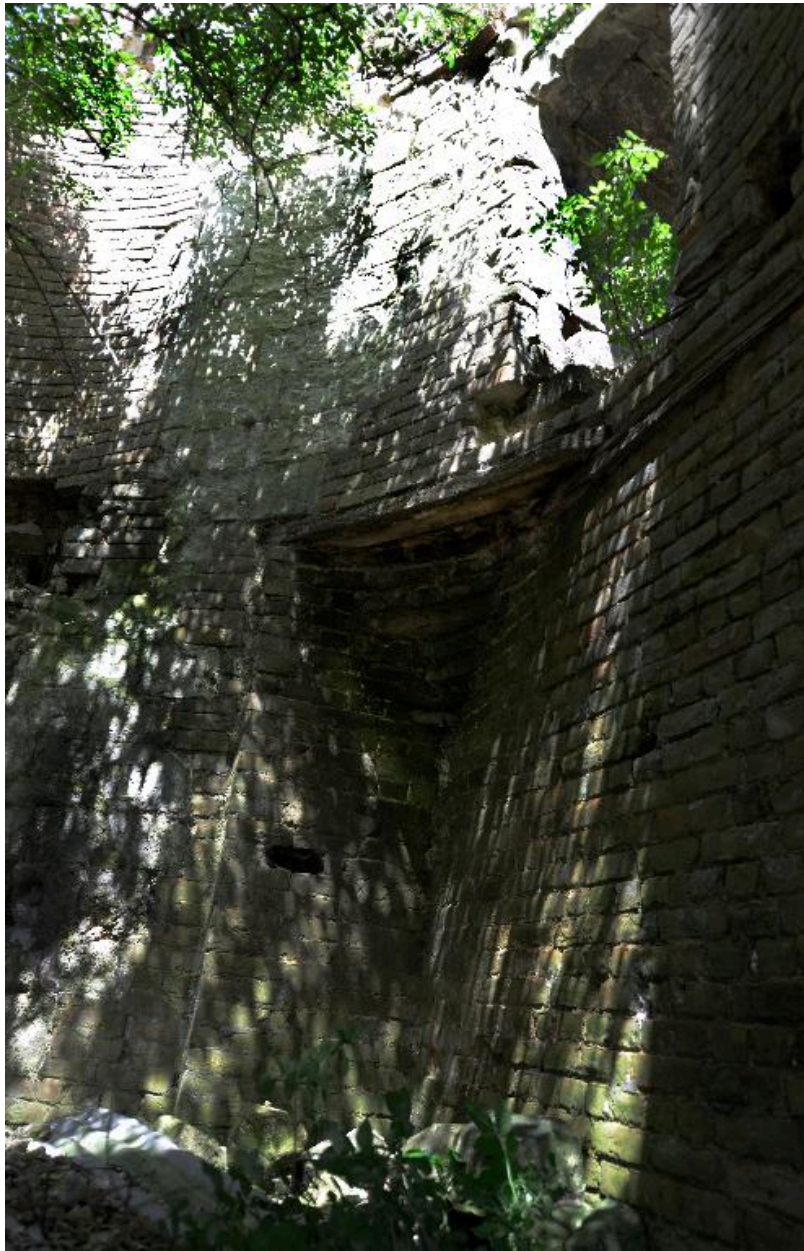
Détail de l'élévation intérieure, premier niveau.
