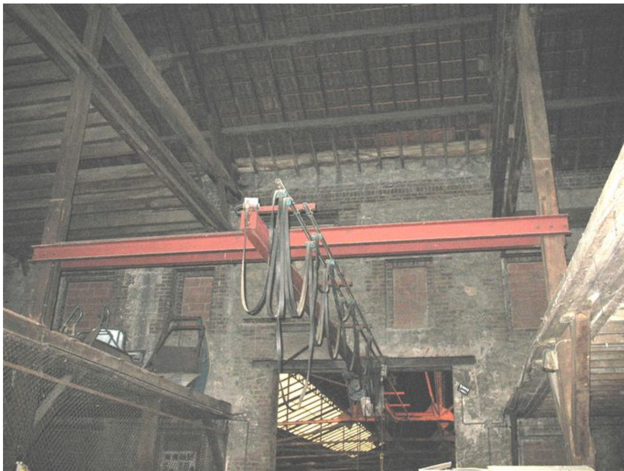
Premier étage de l'ancien relais de chevaux.
