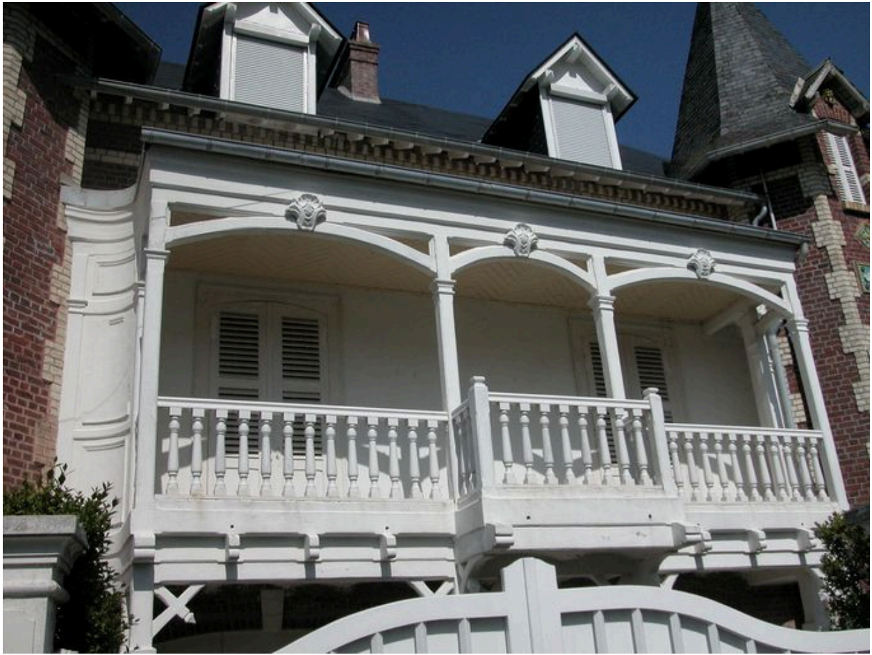
Détail du balcon couvert, façade antérieure.
