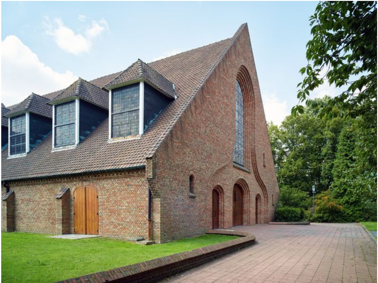
Vue de trois quart de la façade de l'église.
