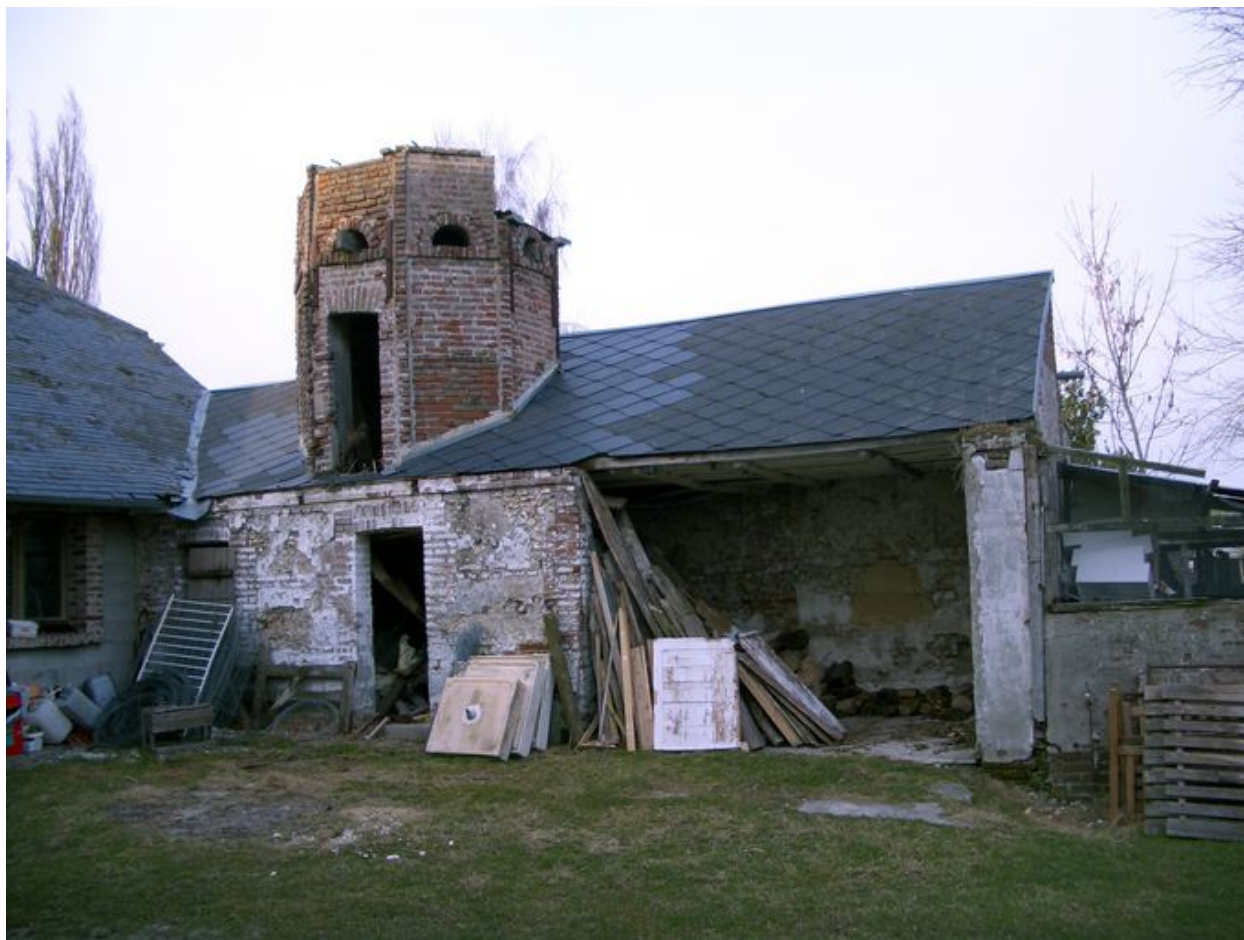
Vue du pigeonnier dans le prolongement du logis.
