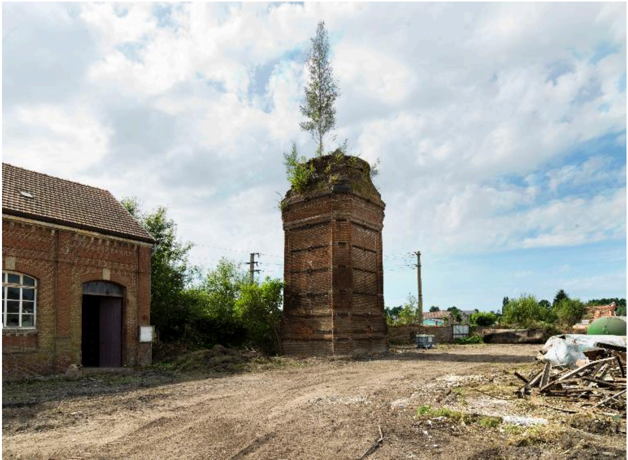
Vestiges de la cheminée de l'usine, juillet 2012.
