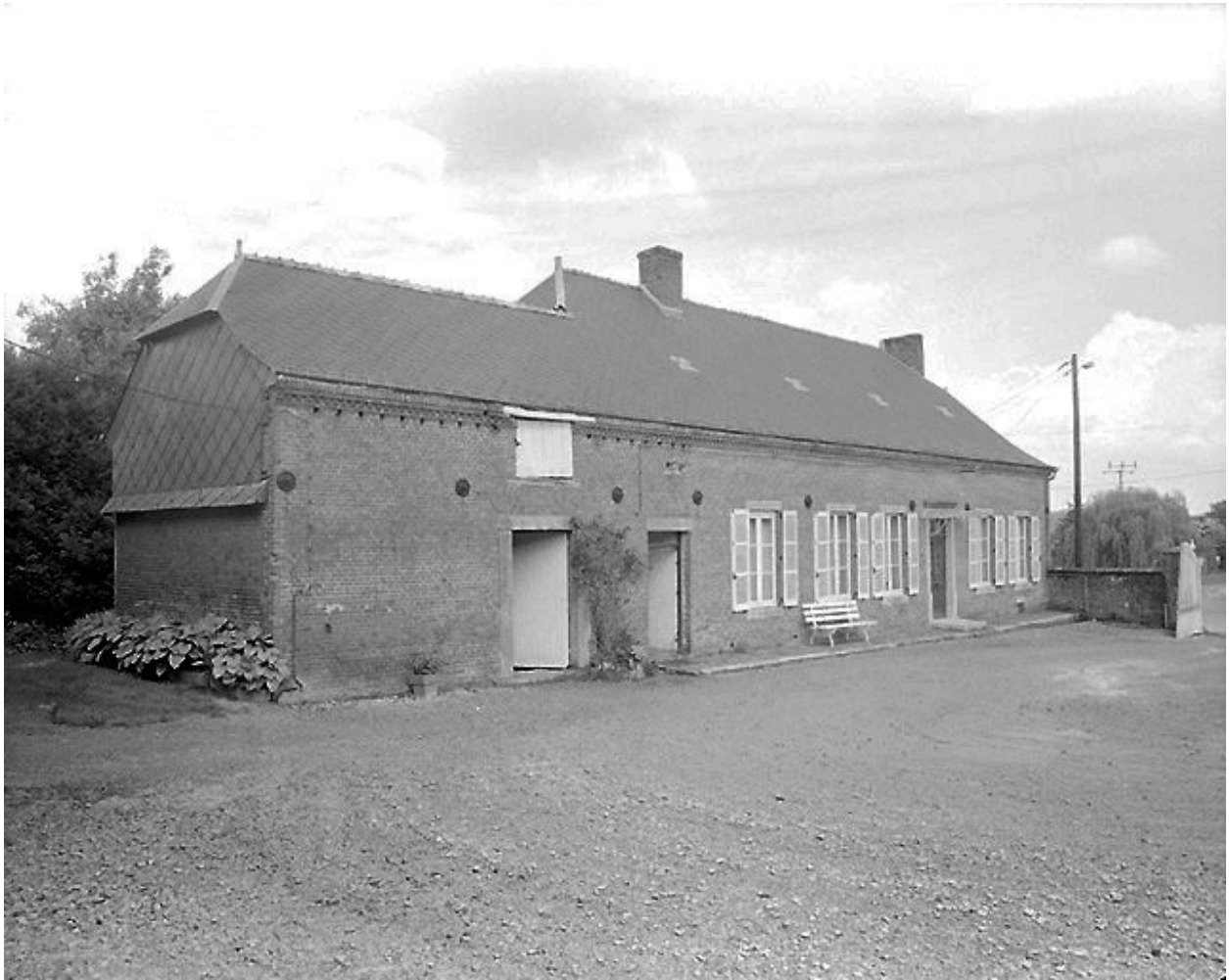
Vue depuis le sud-ouest du logis et de l'étable attenante.
