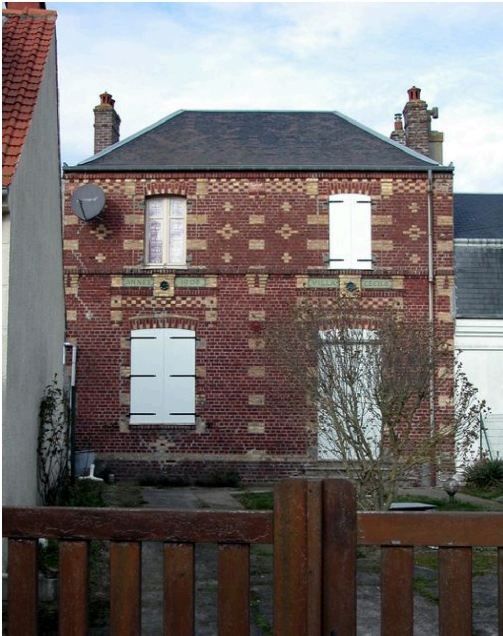
Vue d'ensemble avant travaux.
