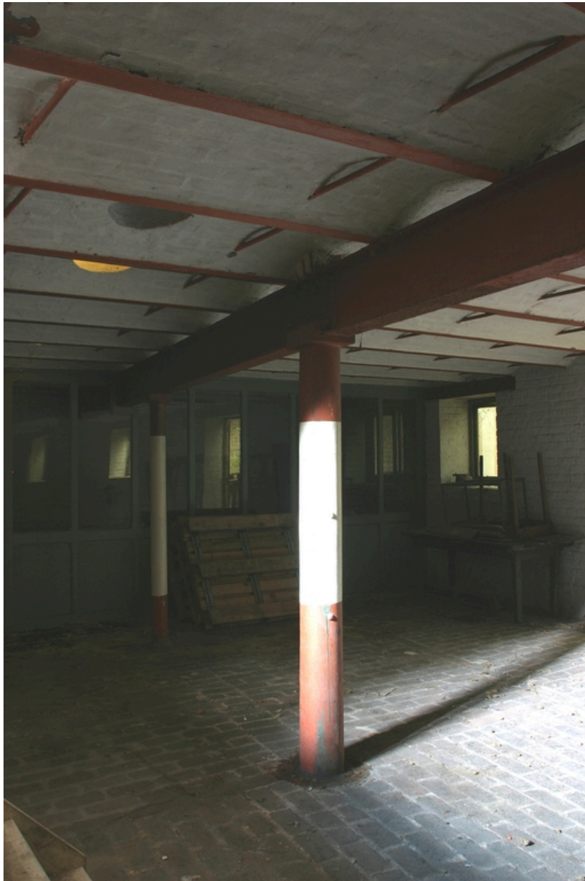
Sous-sol de l'atelier de 1900.
