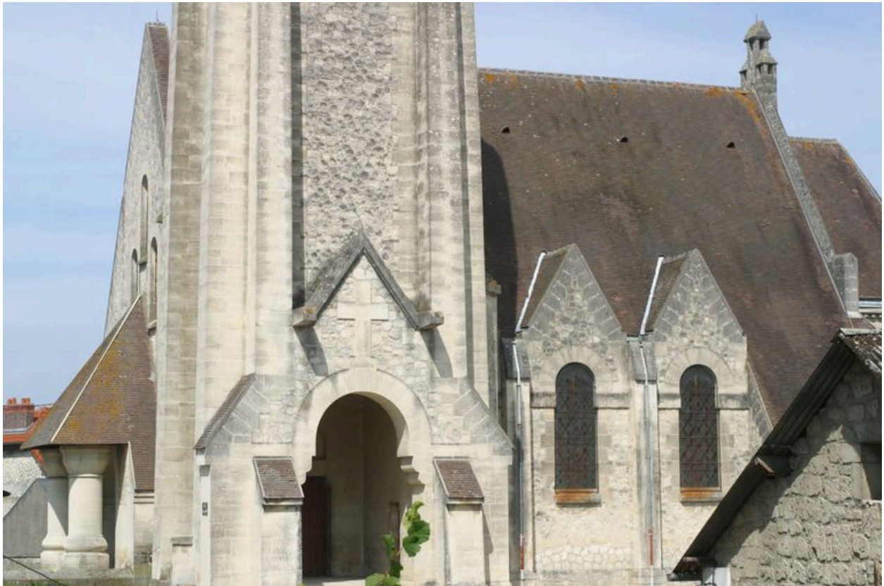
Vue de la face sud.
