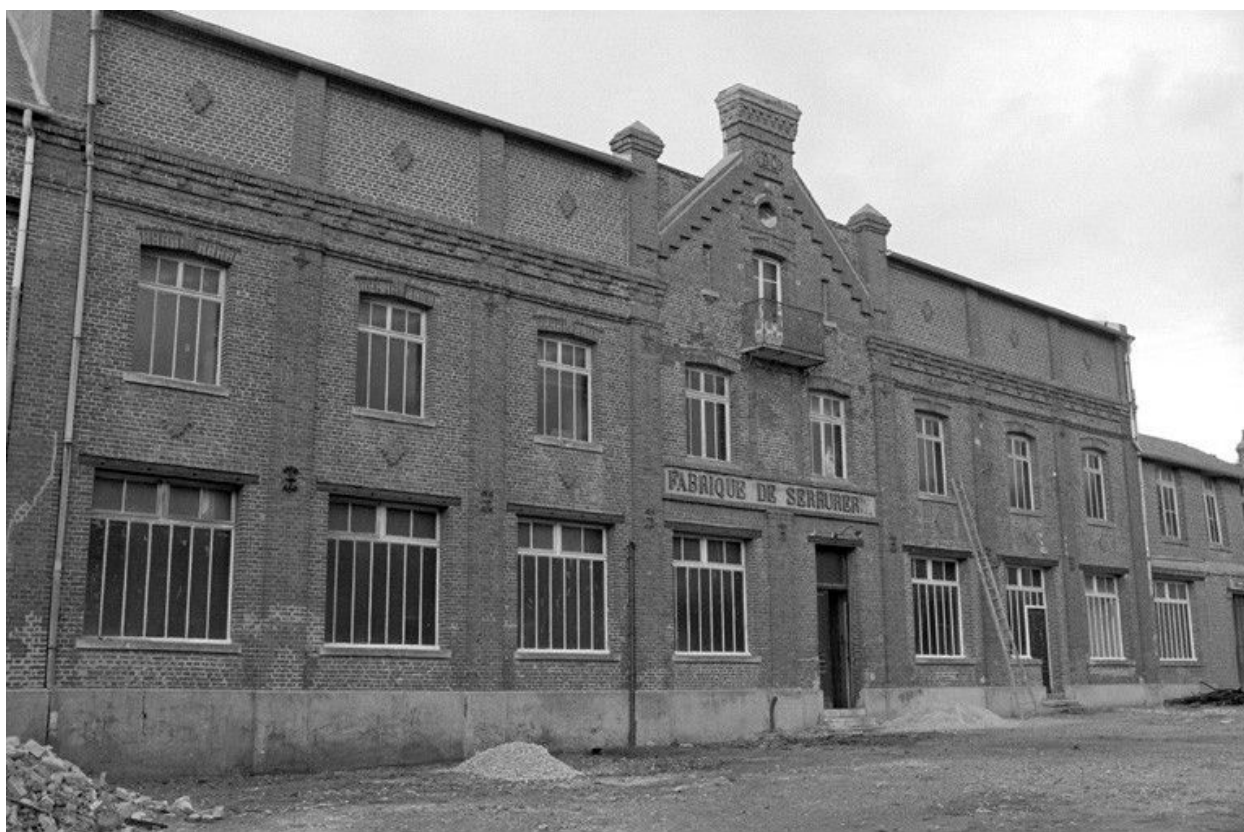
Atelier de fabrication, élévation antérieure, en 1990.
