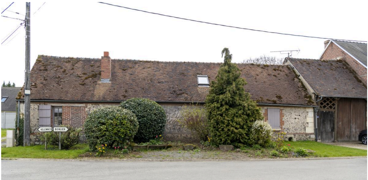
Logis en moellons de silex, n°25 rue de Bonlier, vue depuis le nord.
