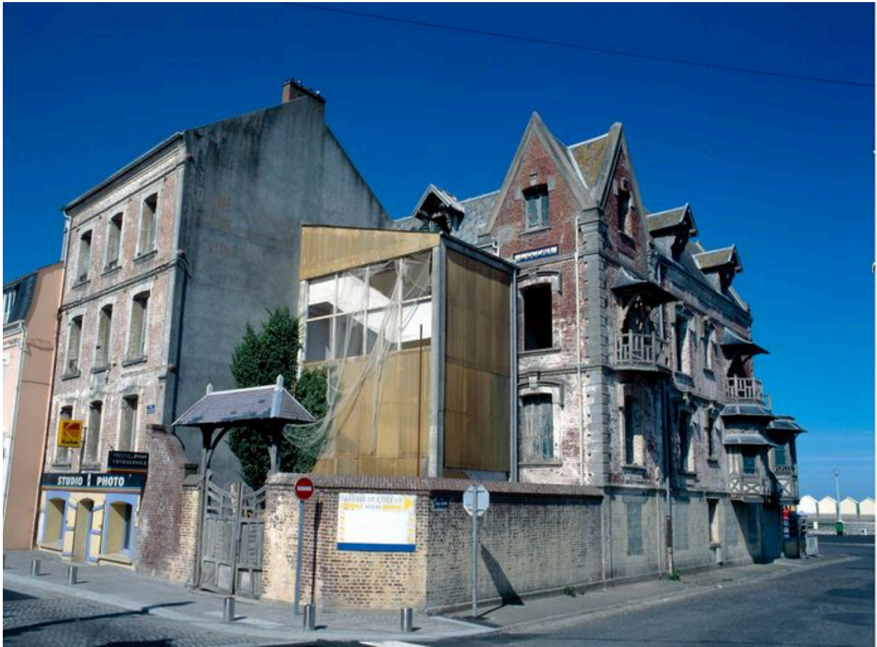
Elévation postérieure, rue du Général-Leclerc.
