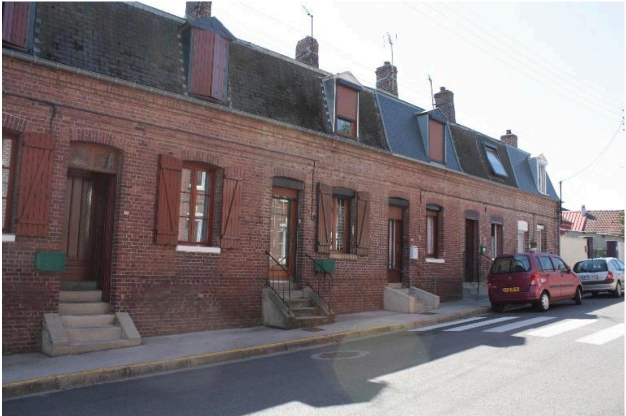
Les maisons ouvrières, rue Ambroise-Croizat.
