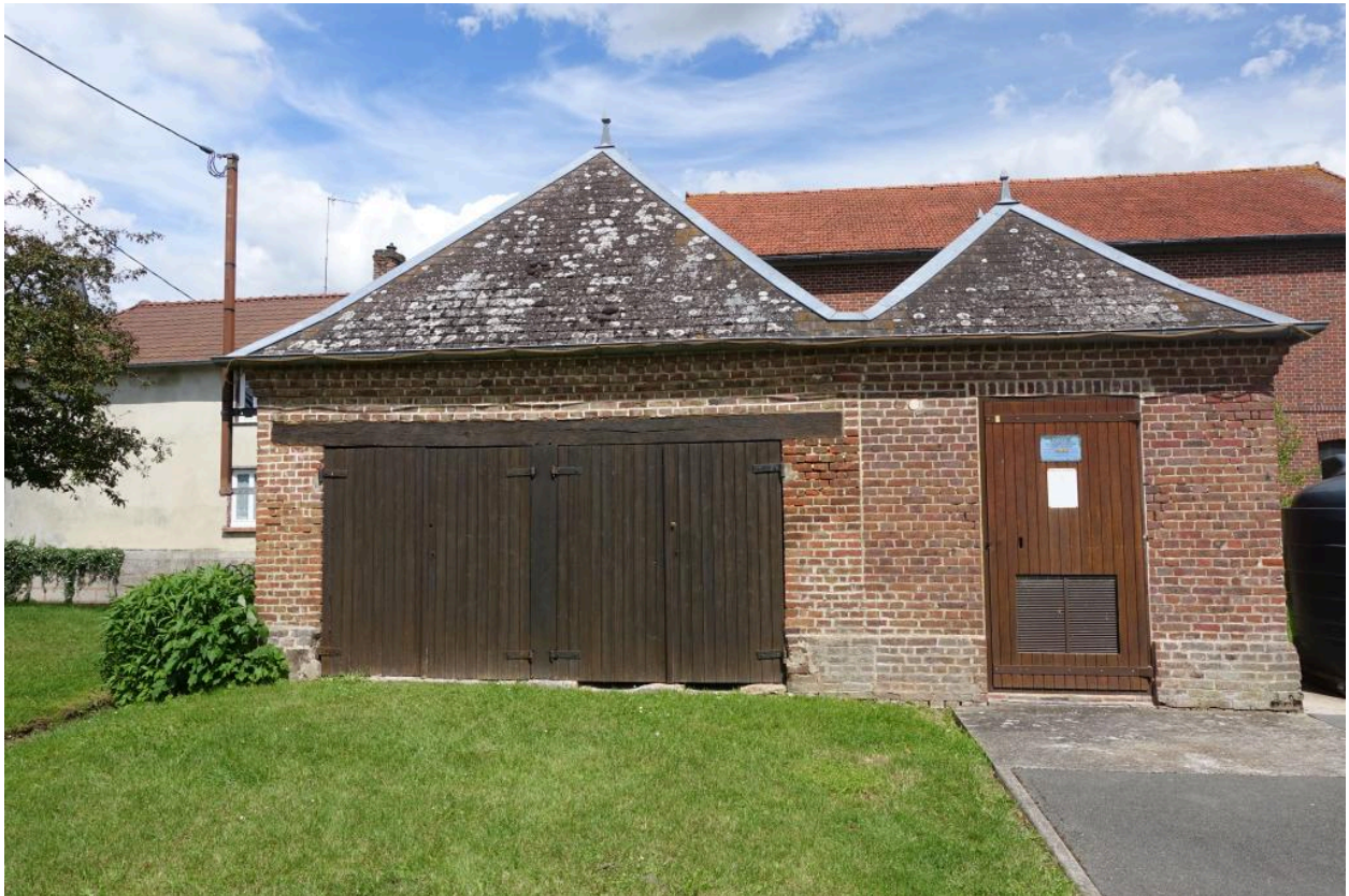
Bâtiment de remise des pompes à incendie, années 1860, vue depuis l'ouest.
