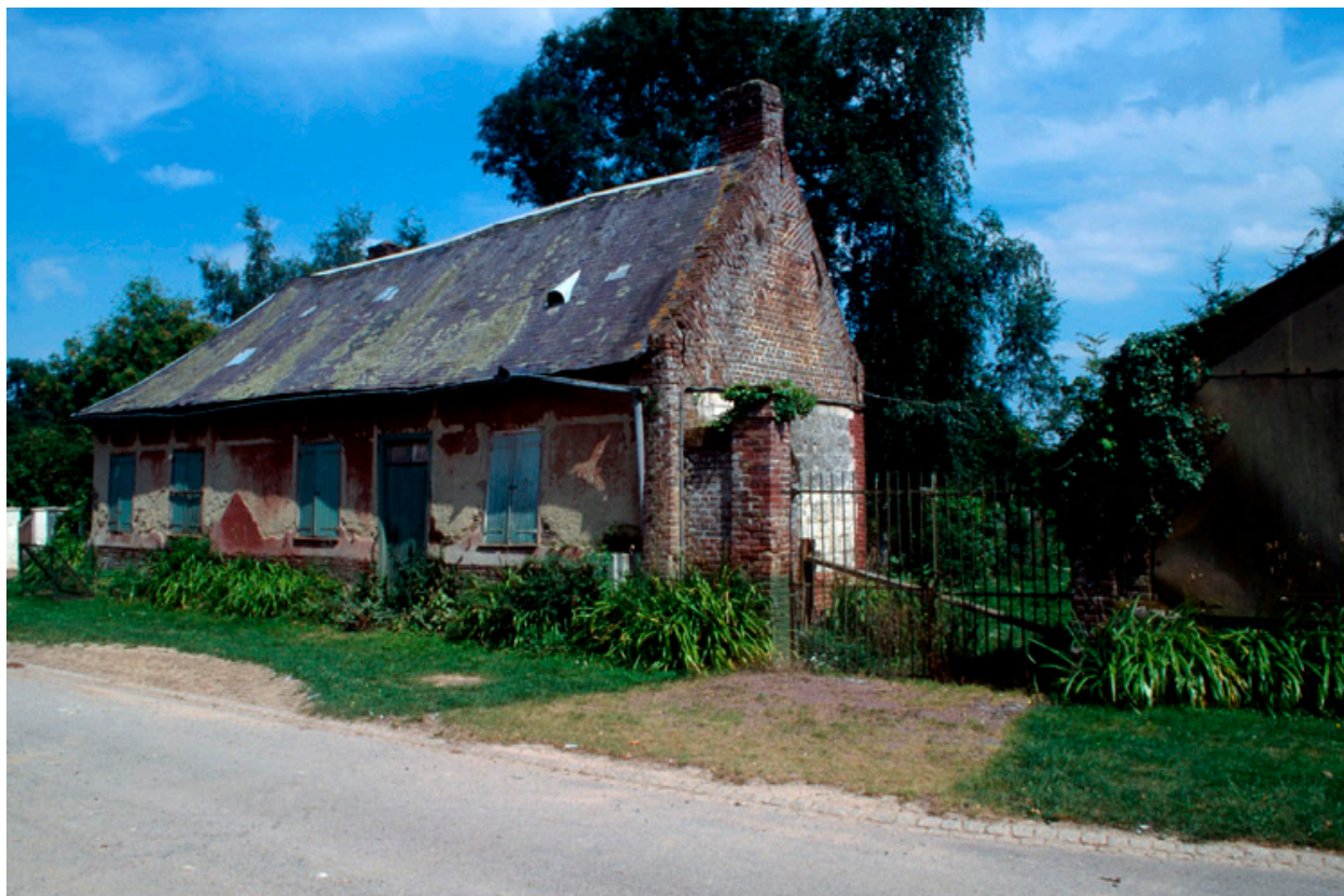
Montonvillers, maison, 3 rue de l'Eglise.
