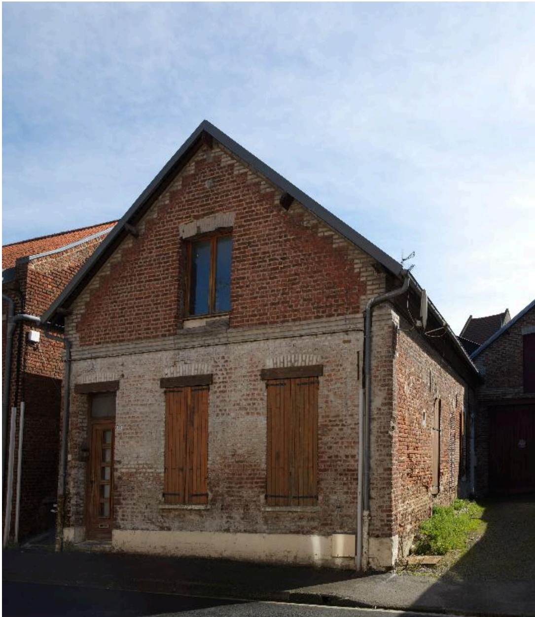
Maison, 23 rue Marchande.
