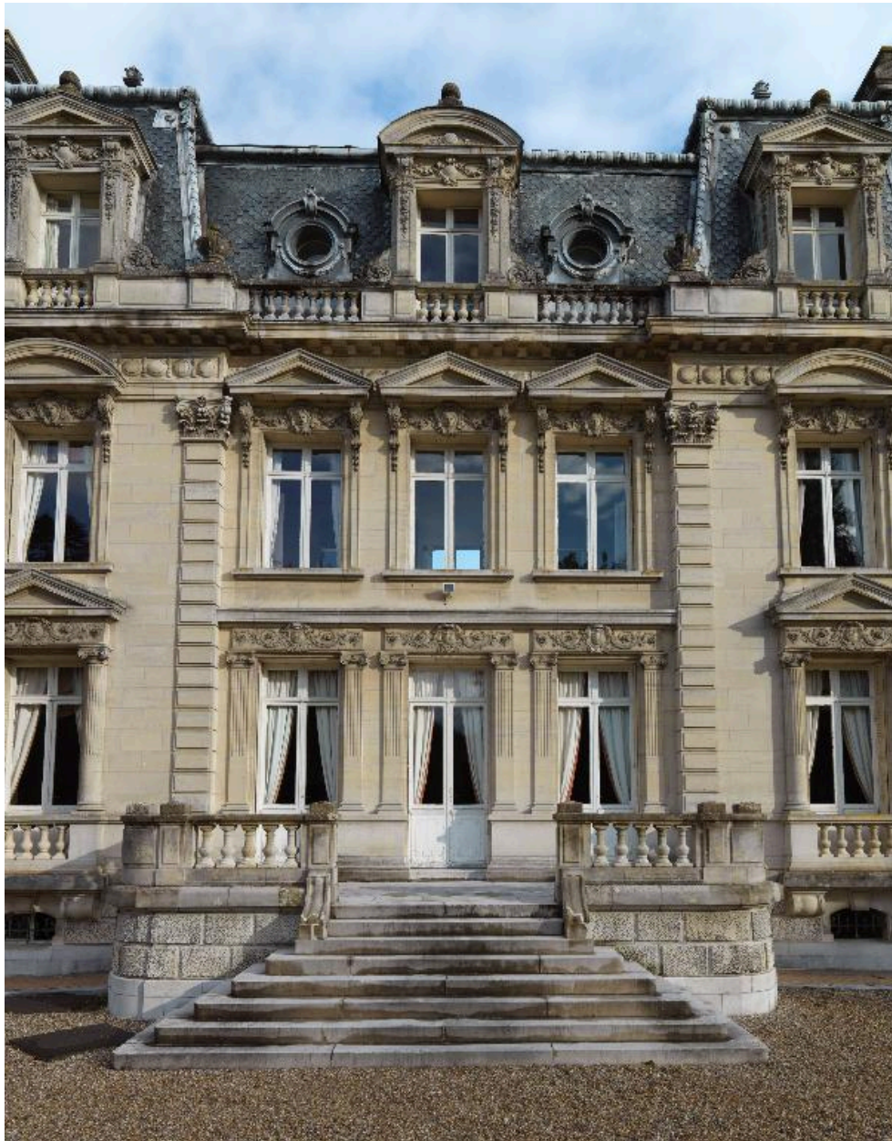
Travée centrale de la façade arrière du logis.
