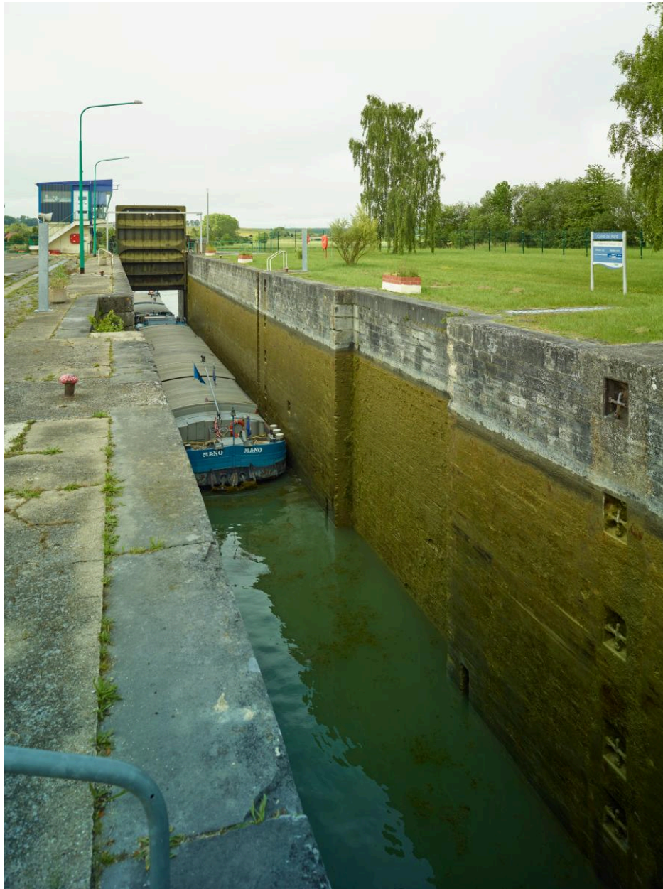
Péniche qui entre dans le sas de l'écluse par la porte levante.
