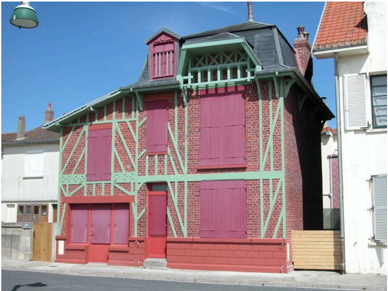
Vue d'ensemble de la maison principale, après restauration.
