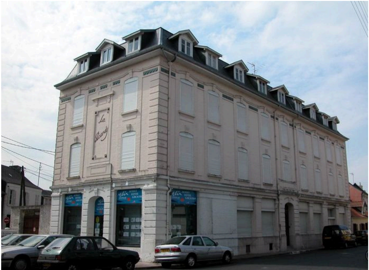
Vue d'ensemble depuis la place Jeanne-d'Arc.
