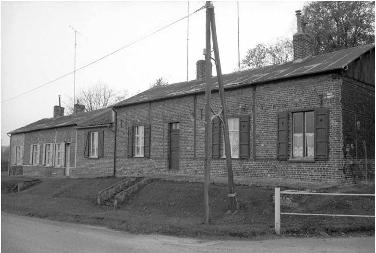
Logement d'ouvriers, vue générale.
