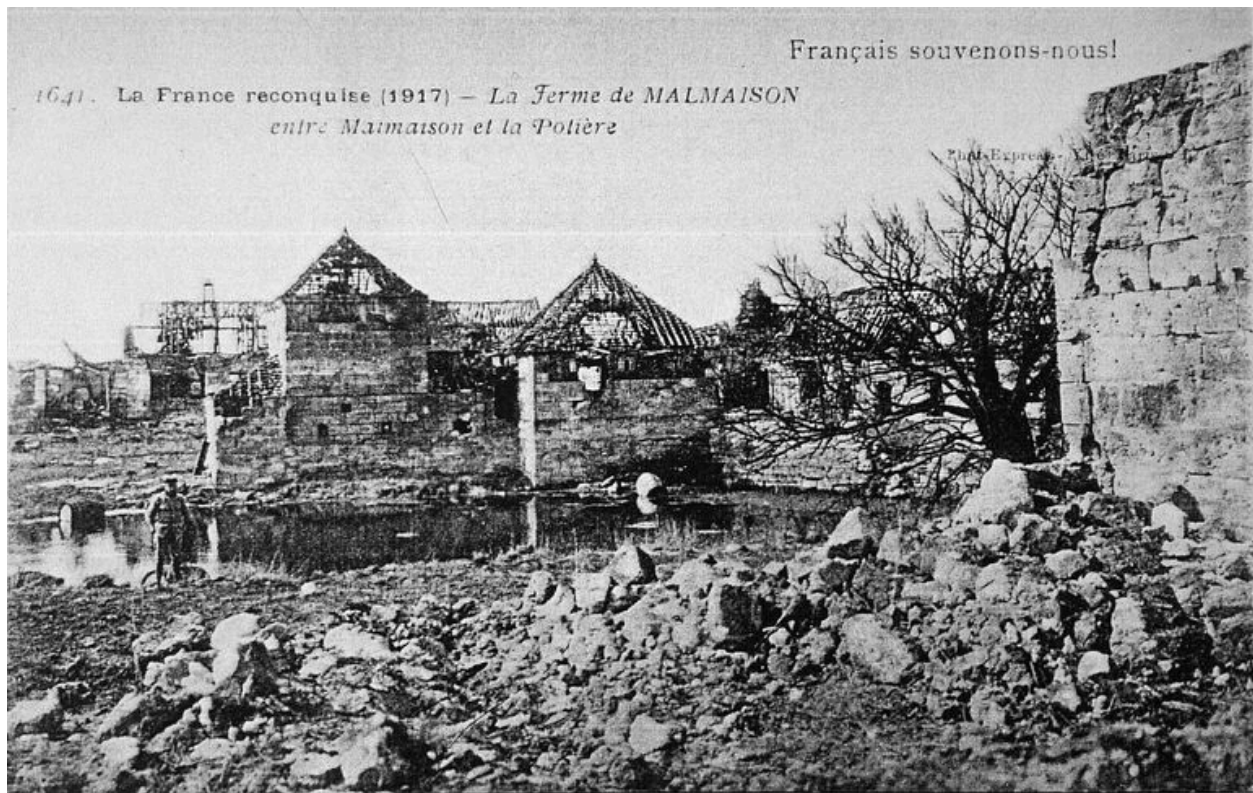
Vue de la ferme en ruines (coll. part).
