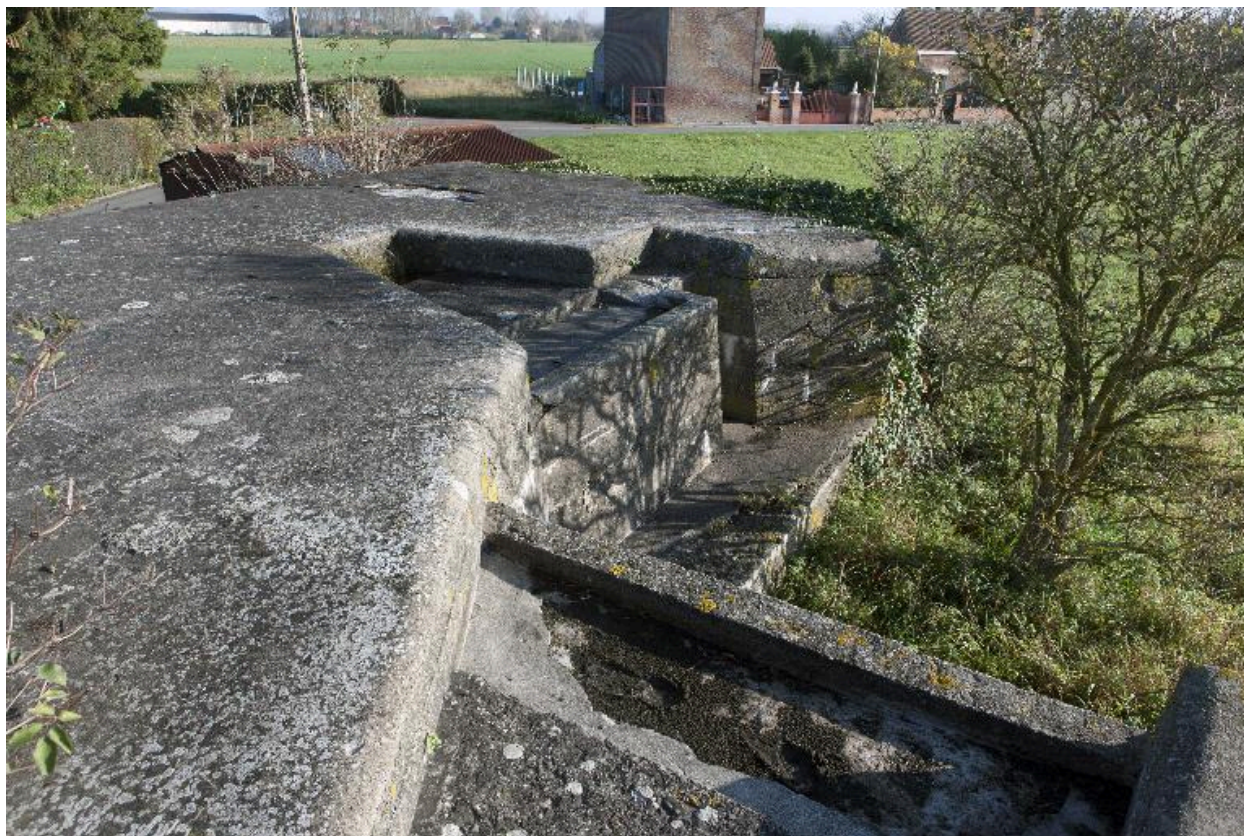
Vue des cuves à mitrailleuse, vers l'est
