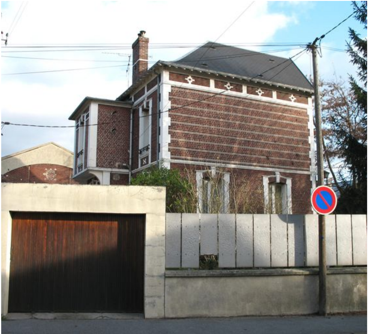
L'ancien logement patronal depuis la rue Jean-de-La-Fontaine.
