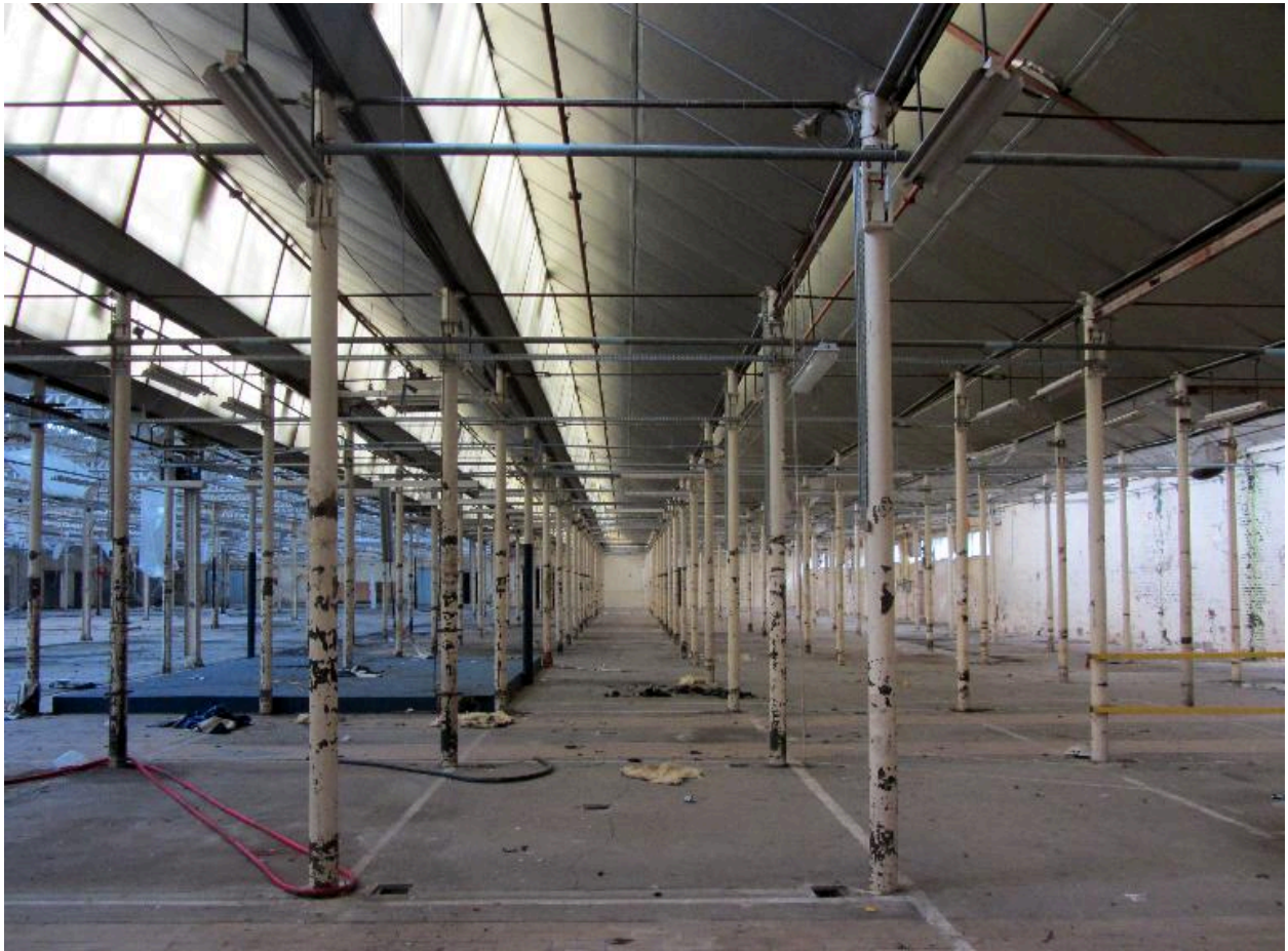
Vue intérieure de l'atelier de filature de jute, avec supports de section circulaire.
