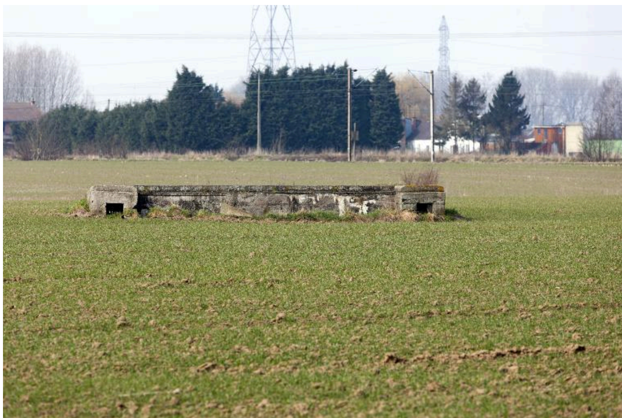
Ouvrage en U, vers l'ouest
