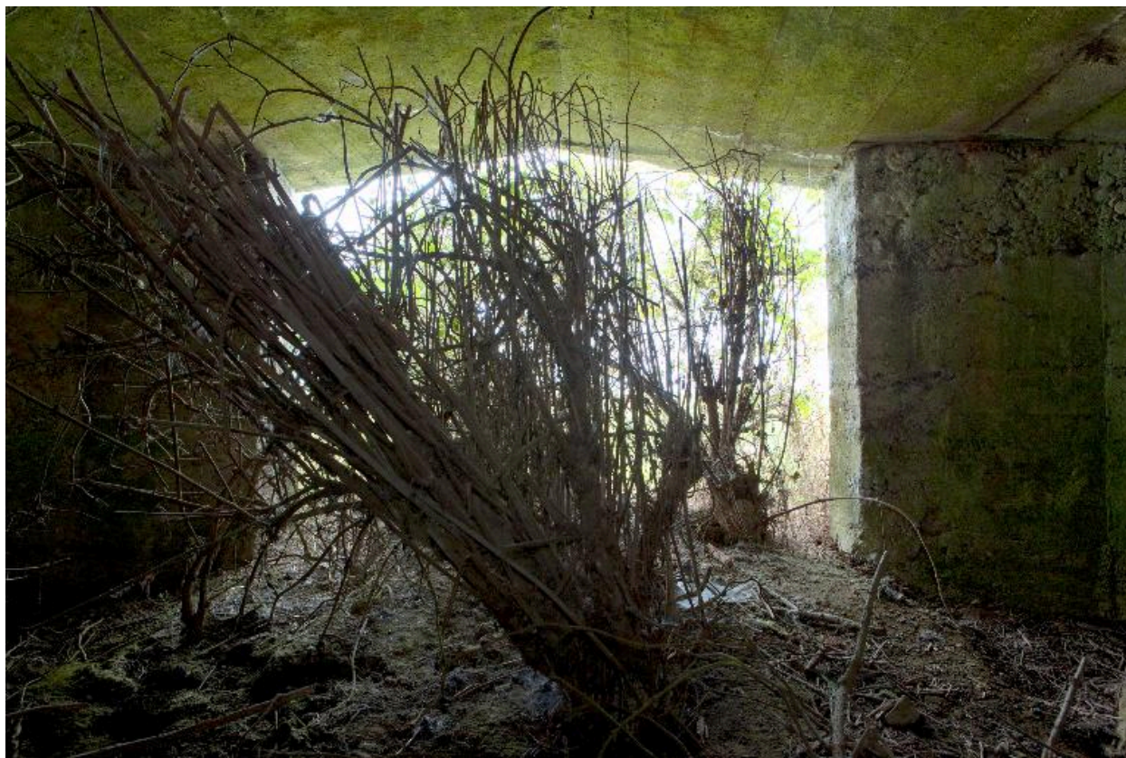
La chambre de tir, vers l'est
