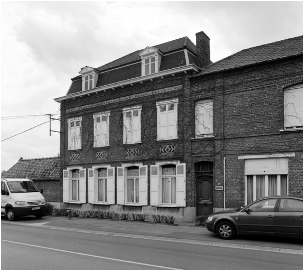
Façade sur rue de la maison patronale.
