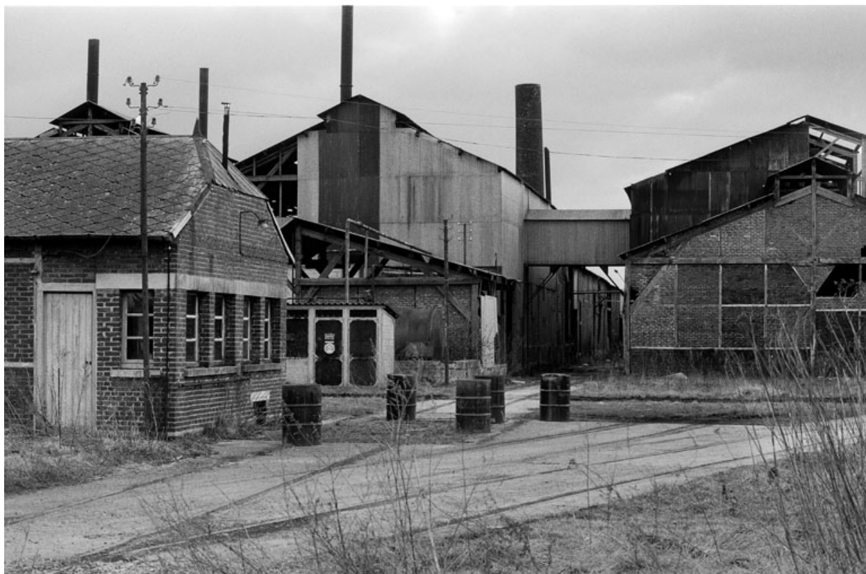
Vue partielle nord-ouest.
