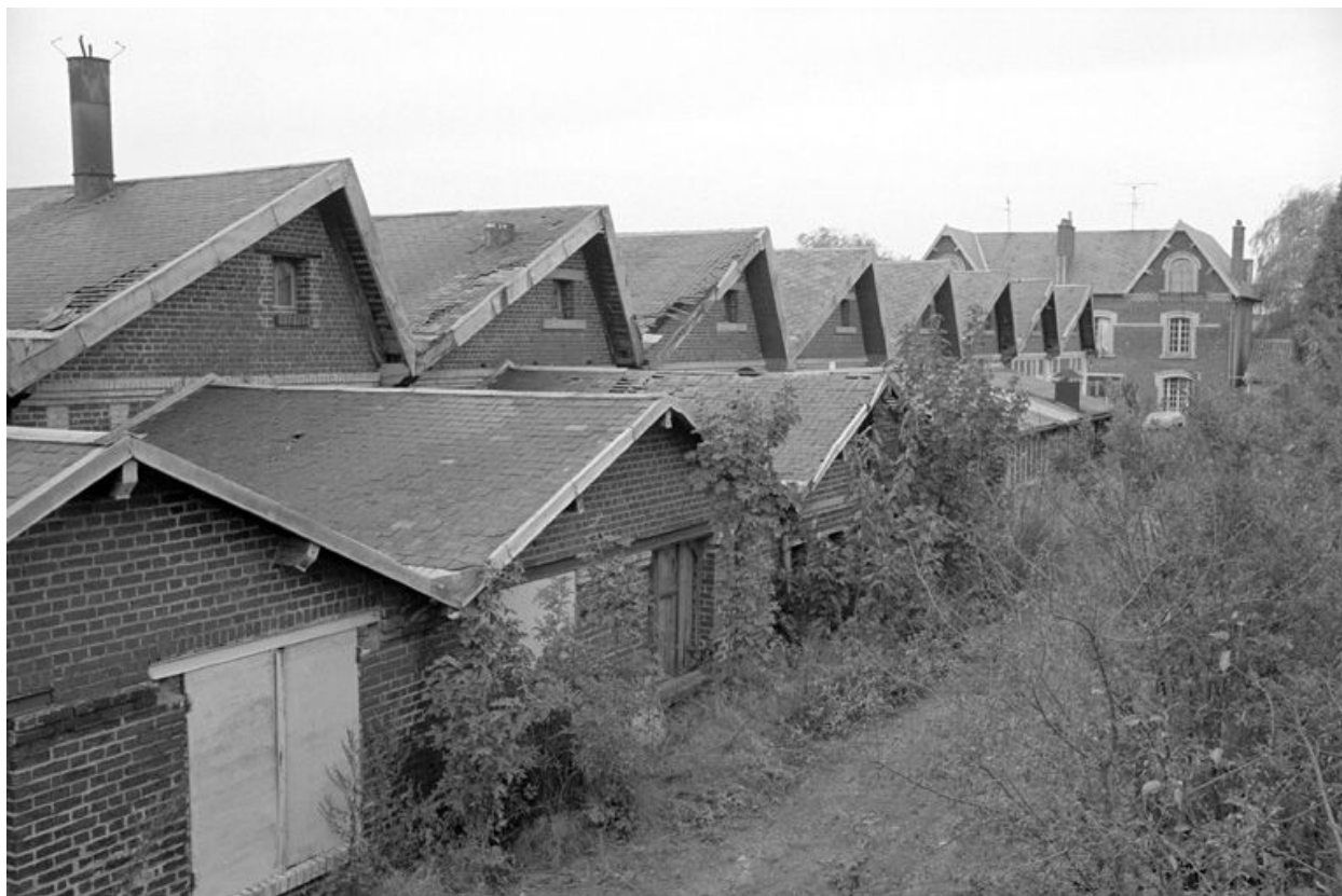
Atelier de fabrication, flanc est.
