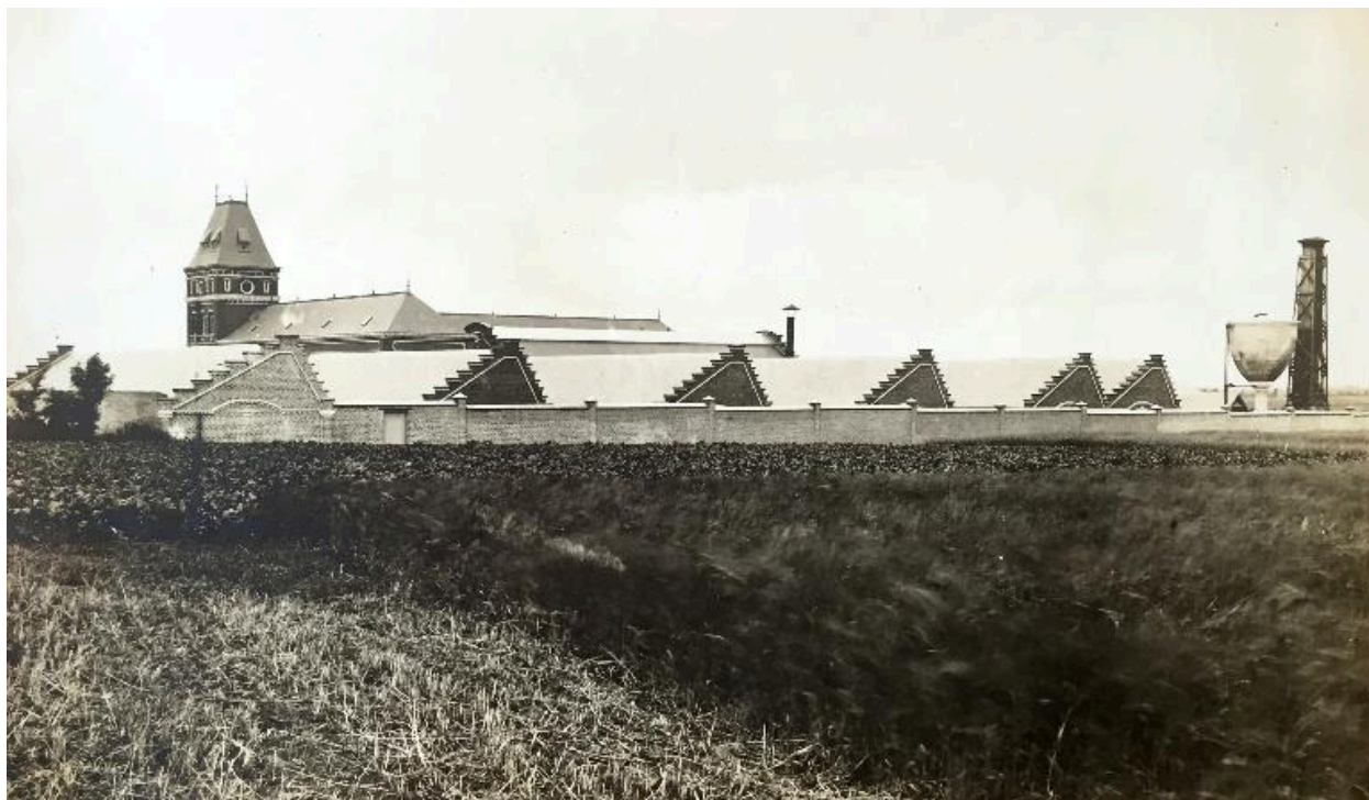
Vue d'ensemble sud-ouest de l'usine reconstruite. 1924. (AD Somme 10 R 1024).
