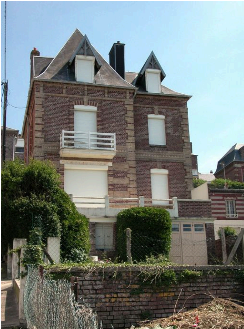
Elévation postérieure, orientée vers la mer.
