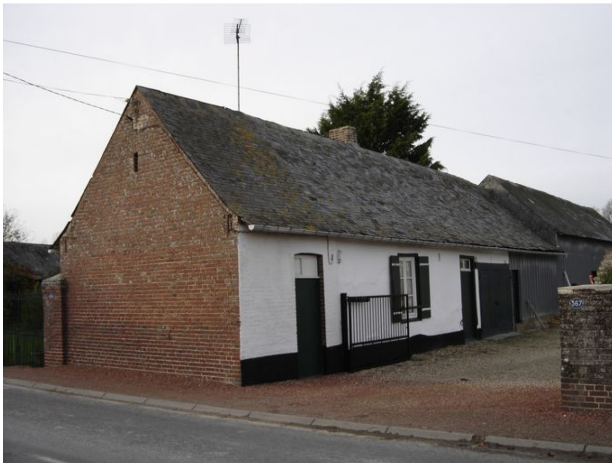
Vue postérieure du logis.
